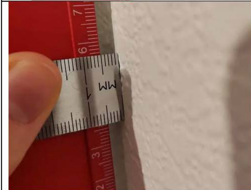
Фото №1 1. Измерение уровня стен кухни в квартире.
