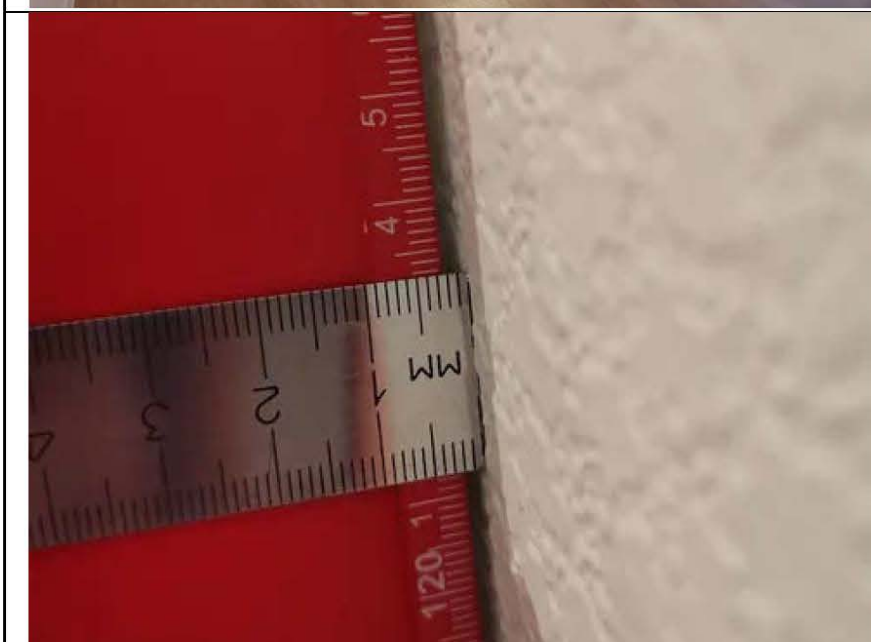
Фото №9. Измерение уровня стен коридора в квартире.
