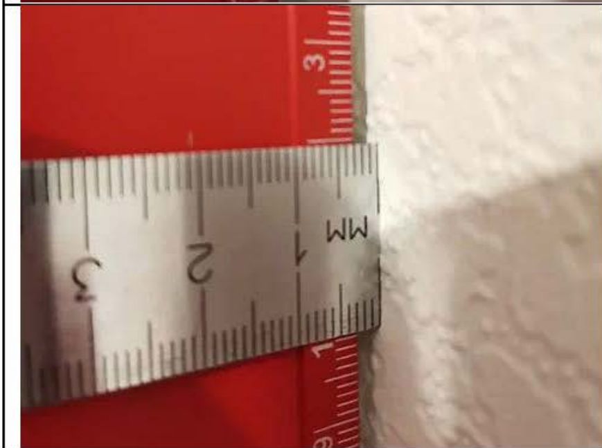
Фото №1 2. Измерение уровня стен гостиной в квартире.
