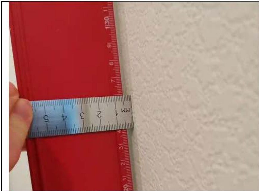
Фото №1 0. Измерение уровня стен холла в квартире.
